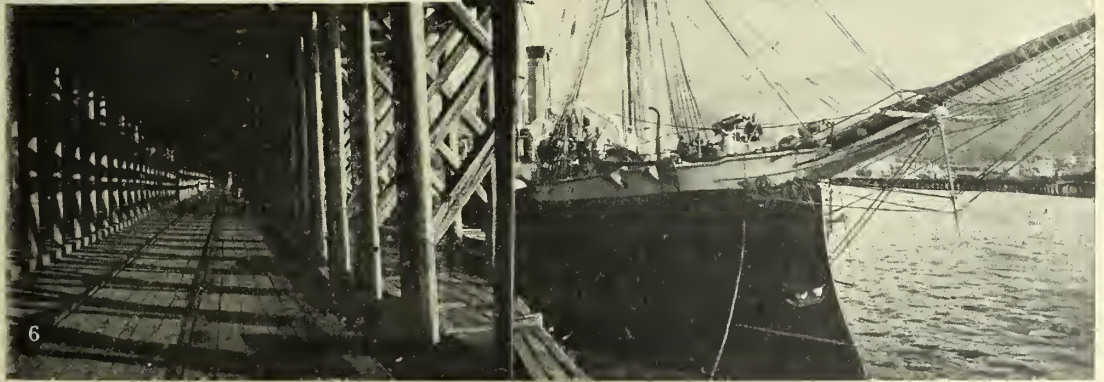
1. Novorossiisk. — 2. Carrières de ciment. — 3. Démbarcadère de Sébastopol. — 4. Le Donetz . — 5. Les élévateurs. — 6. Le grand wharf et le Donetz .
