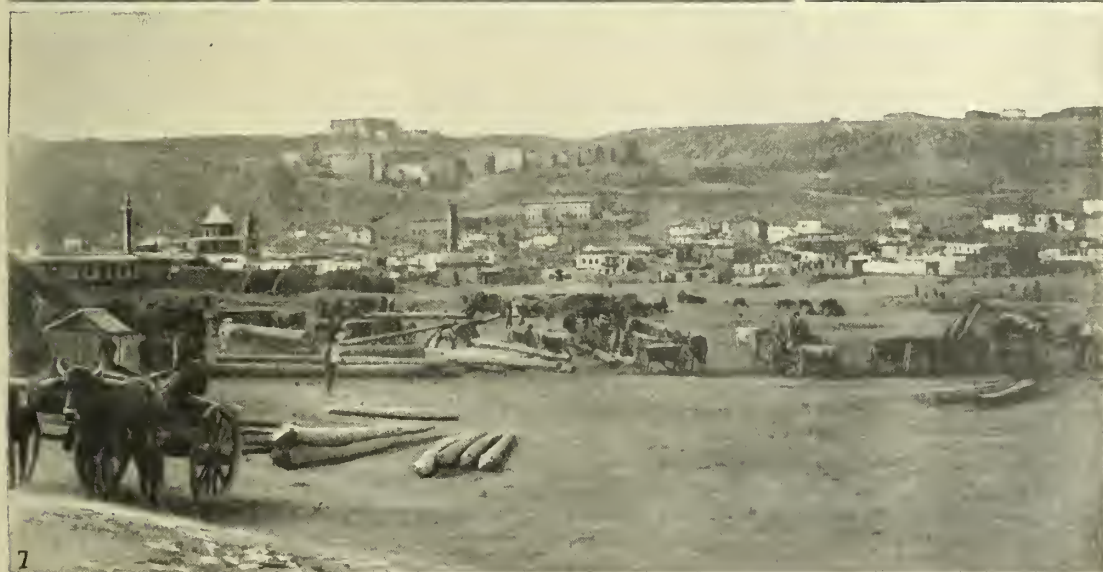
KARS : 1 et 7. Vue générale. — 2. Minaret. — 3. Pont. — 4. Citadelle. — 5. Faubourg arménien. — 6. Cathédrale.
